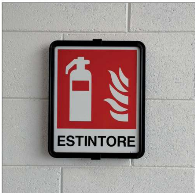
INSTALLAZIONE DI SEGNALI MONOFACCIALI
