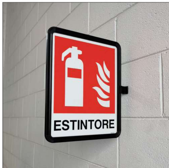
INSTALLAZIONE DI SEGNALI BIFACCIALI
